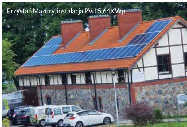
Dom jednorodzinny, instalacja PV 5,61KWp
